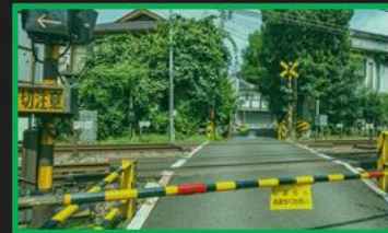
踏切侵入検出
