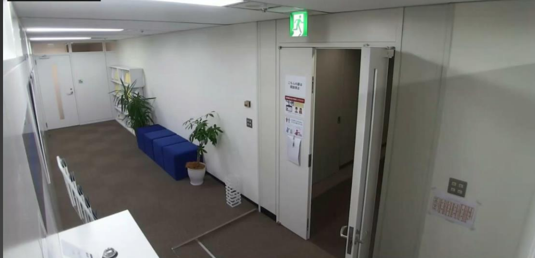
出入口の上部、精度80-99%
